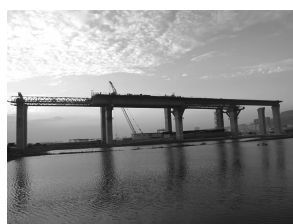
北汉北引桥现浇箱梁
